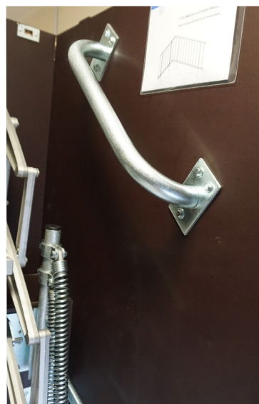
Main-courante dans caisson
