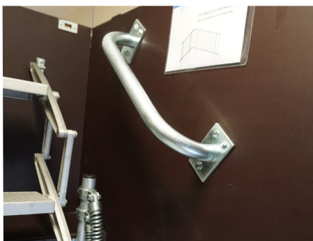
Main-courante dans caisson
