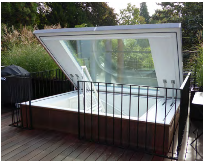
Motoren verdeckt montiert (Austritt seitlich)
